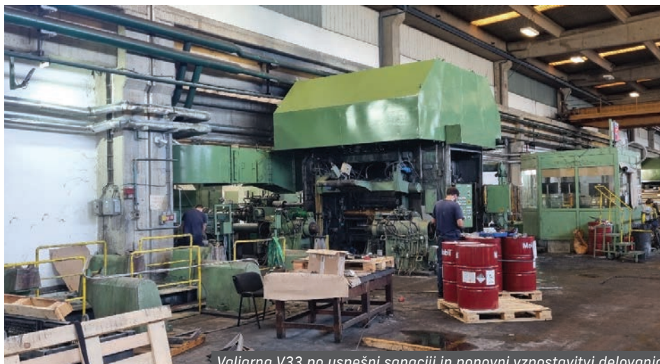
Valjarna V33 po uspešni sanaciji in ponovni vzpostavitvi delovanja
