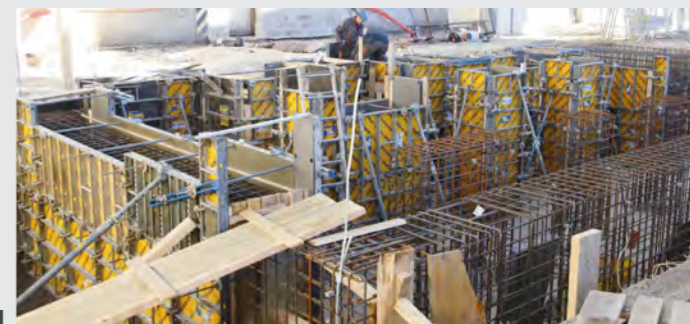
Gradnja tehnološkega temelja; spodaj 3D slika, desno dejansko trenutno stanje
