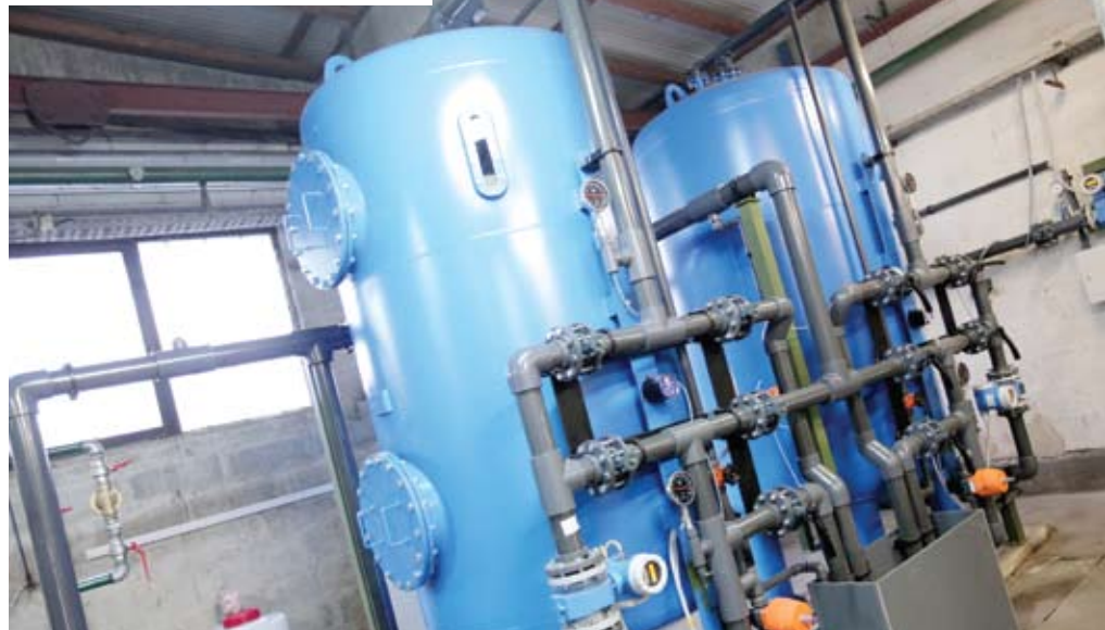
Peščeni filtri bodo obdelali tehnološko vodo
