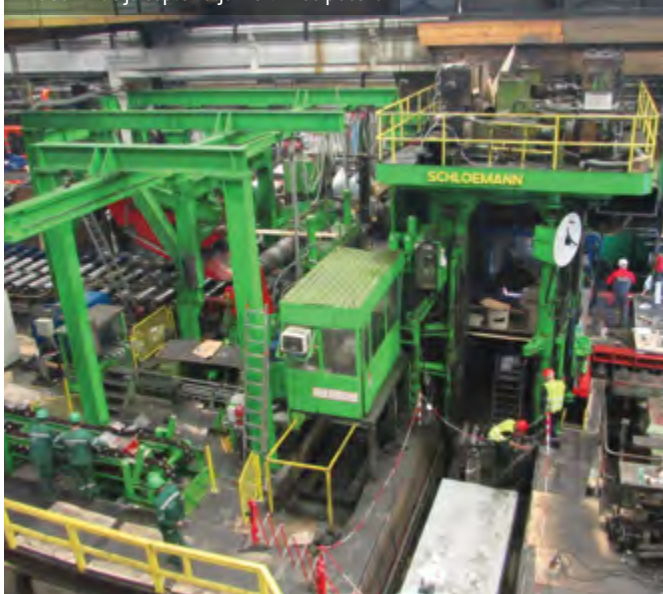
Modernizacija tople valjarne V-2 še poteka
